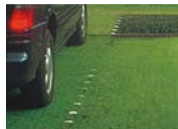
Réalisation d'un parking gazonné avec dalles Aco
