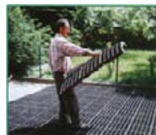
Montage des plaques Ecogreen
